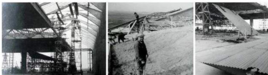
De gauche à droite : Vue depuis les lanterneaux côtés appentis. Vue du coulage d'un voile mince de couverture. Vue du levage d'une porte métallique Source : Service Local d'Infrastructure D.R
