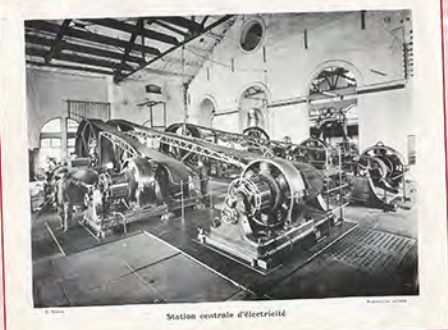
Station centrale d'électricité
