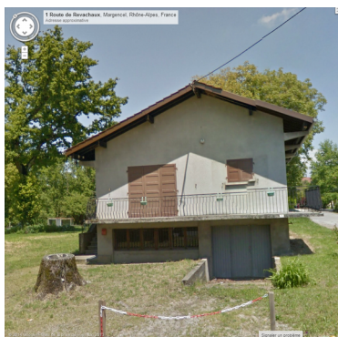
« Villa Revachaux » à Margencel (74)
