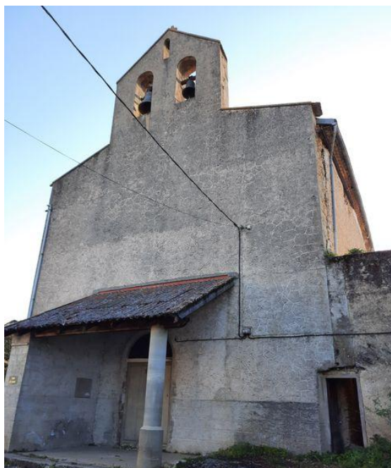
Façade Ouest, mur Clocher
