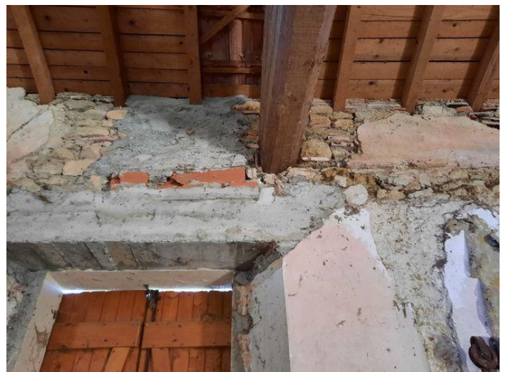
Modifications de maçonnerie pour création d'ouvertures
