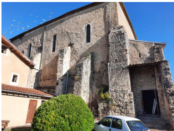
Portion Est de la façade Sud
