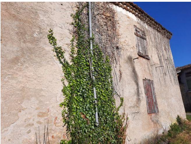
Descente d'eaux pluviales en façade Est
