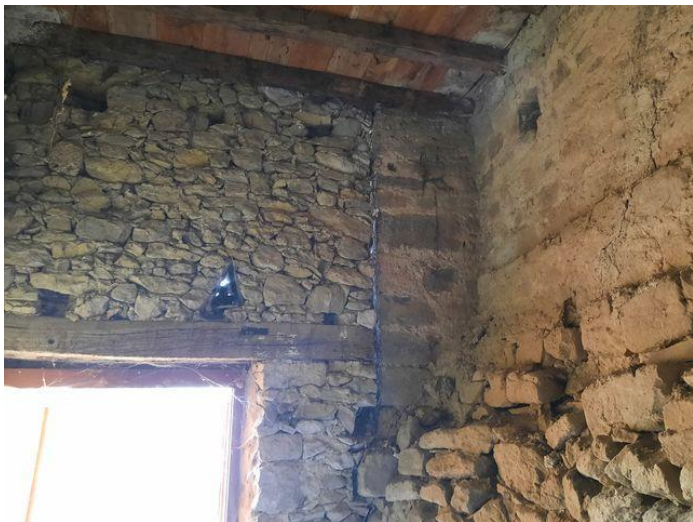
Mur Est depuis le dessous de la sacristie
