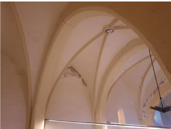
Tirant (câble) de la première travée
