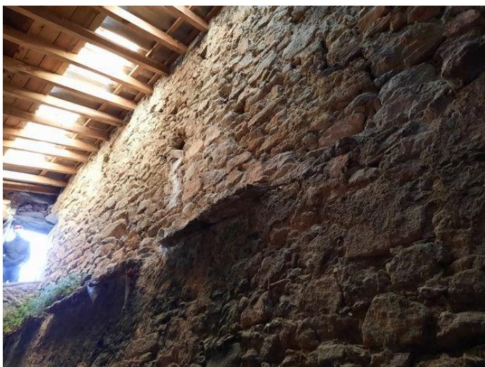
Mur Sud de l'église
