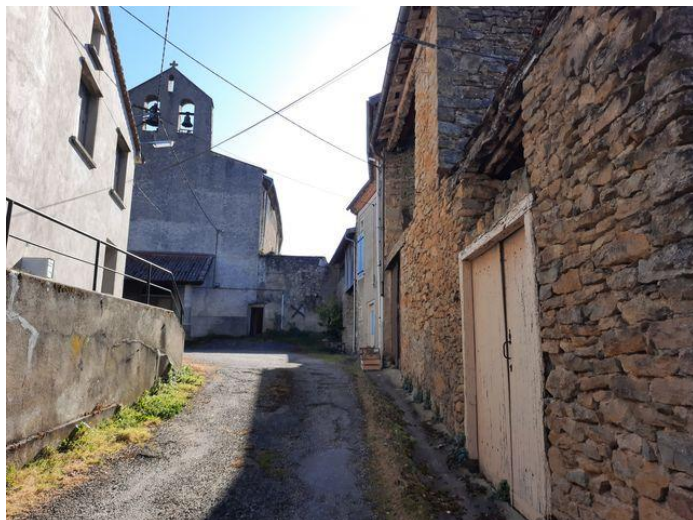
Vue sur le mur Sud depuis la ruelle d'accès
