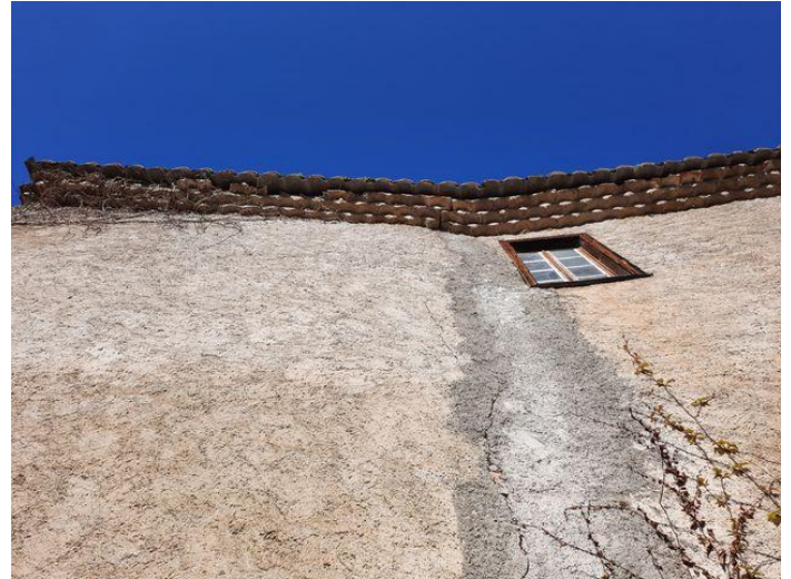
Partie haute du mur
