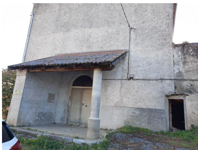
Revêtement du mur clocher
