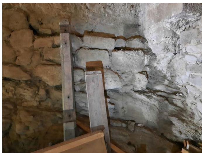
Angle Nord-Est bâti sur la roche
