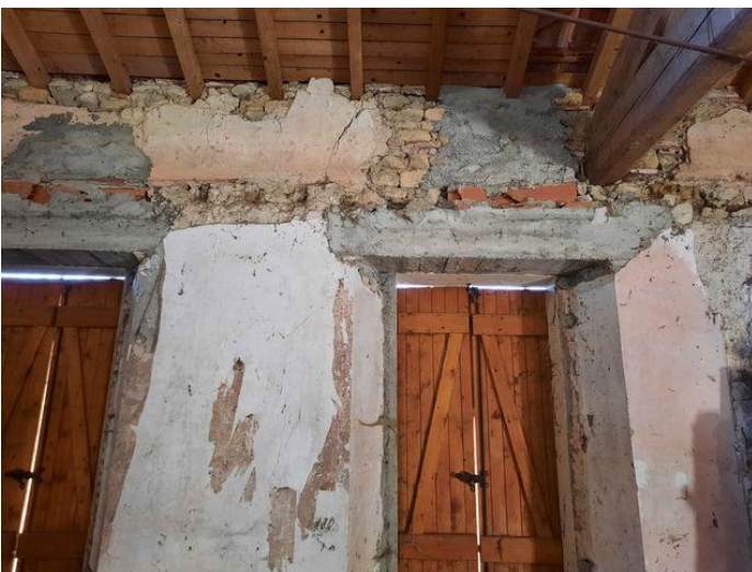
Modifications de maçonnerie pour création d'ouvertures
