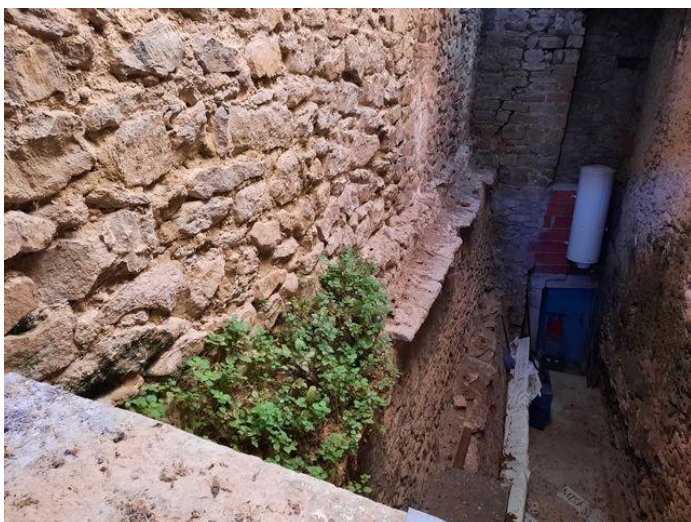
Mur Sud de l'église
