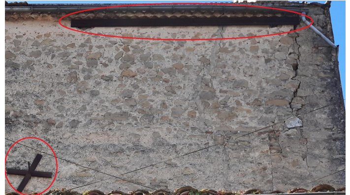
Tirants et clés en angle Nord-Ouest
