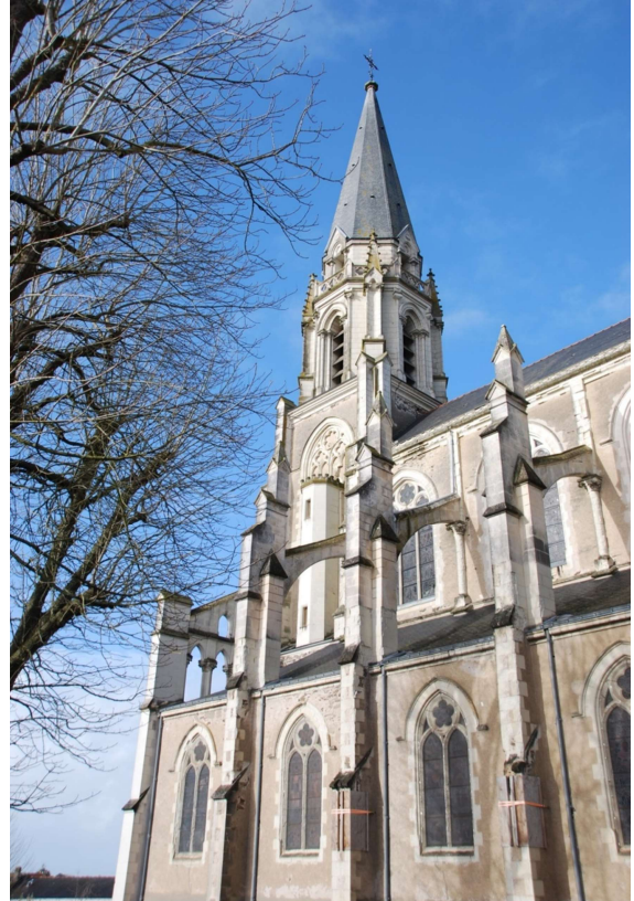
Contreforts et arcs-boutants de la nef et bas-côtés ASPCRB
