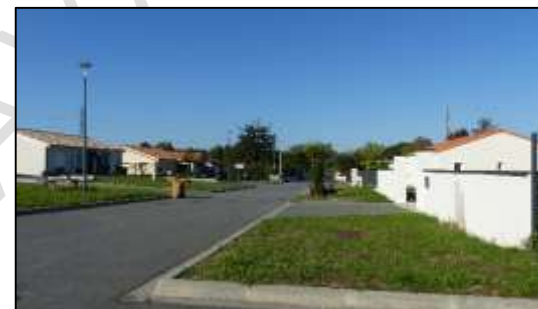
La rue centrale de la zone 1AU de la Guinodine
